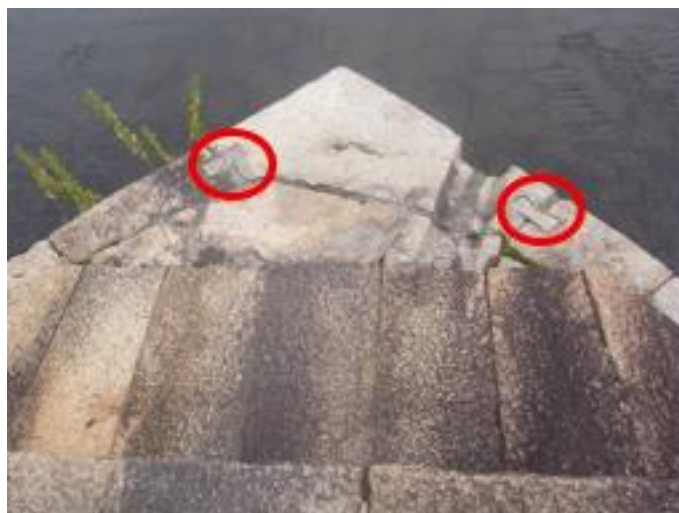
写真2：三つのアーチ橋を支える橋脚
