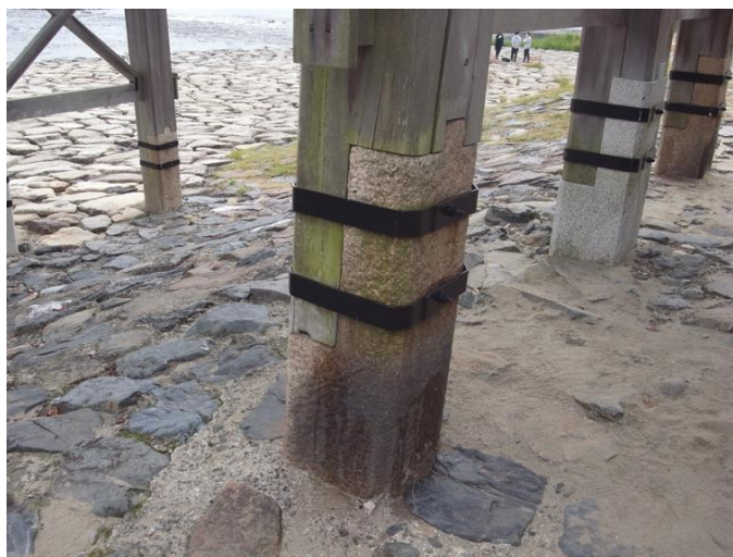
写真3：両端の桁橋を支える橋杭
