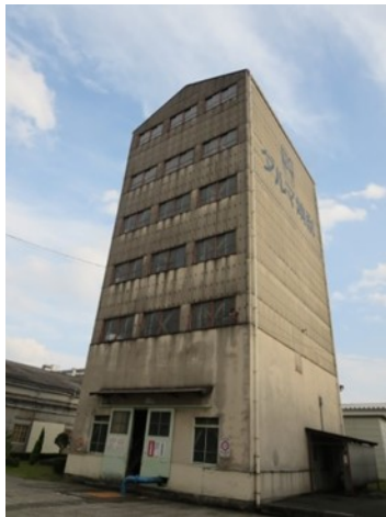
昔の蒸留塔建屋
