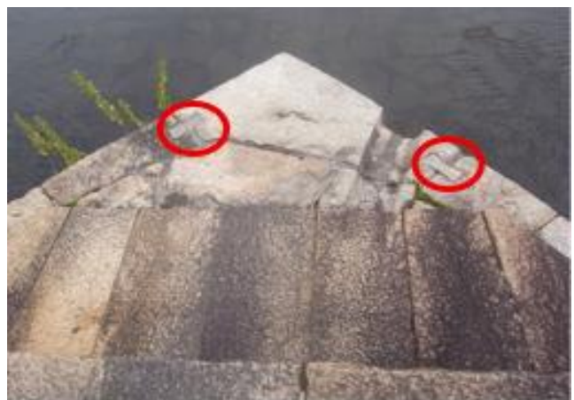
写真2: 三つのアーチ橋を支える橋脚
