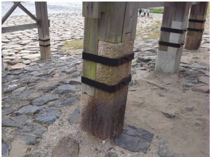
写真3: 両端の桁橋を支える橋杭
