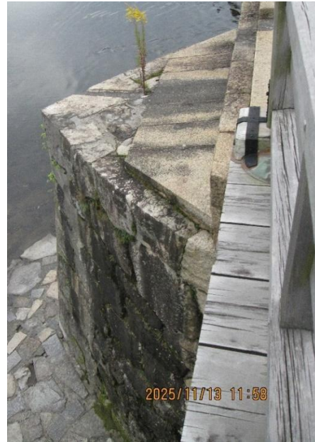
写真4:橋上から見た橋脚
