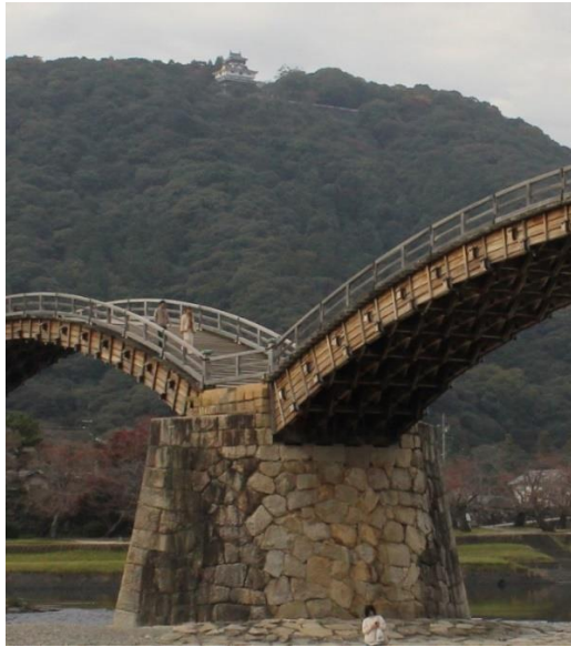
写真3：河原から見た橋脚 (山頂に岩国城を望む)
