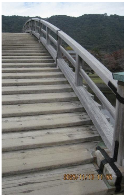
写真5：板を積み重ねた階段
