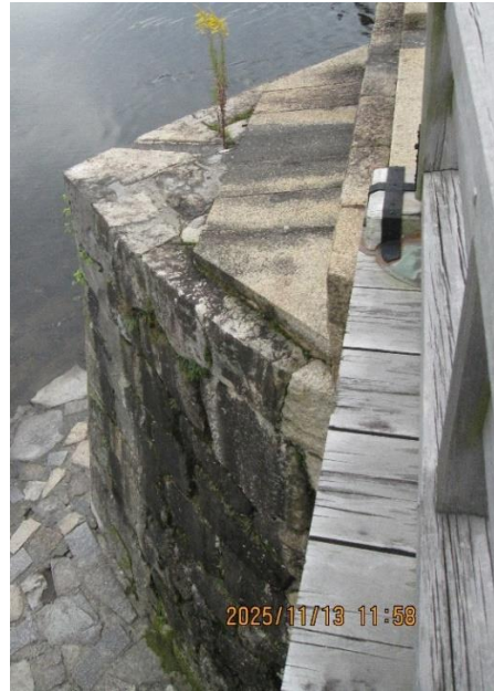
写真4：橋上から見た橋脚
